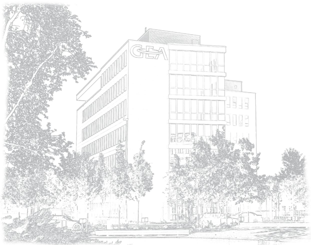
Das neue GEA Center am Flughafen Düsseldorf
